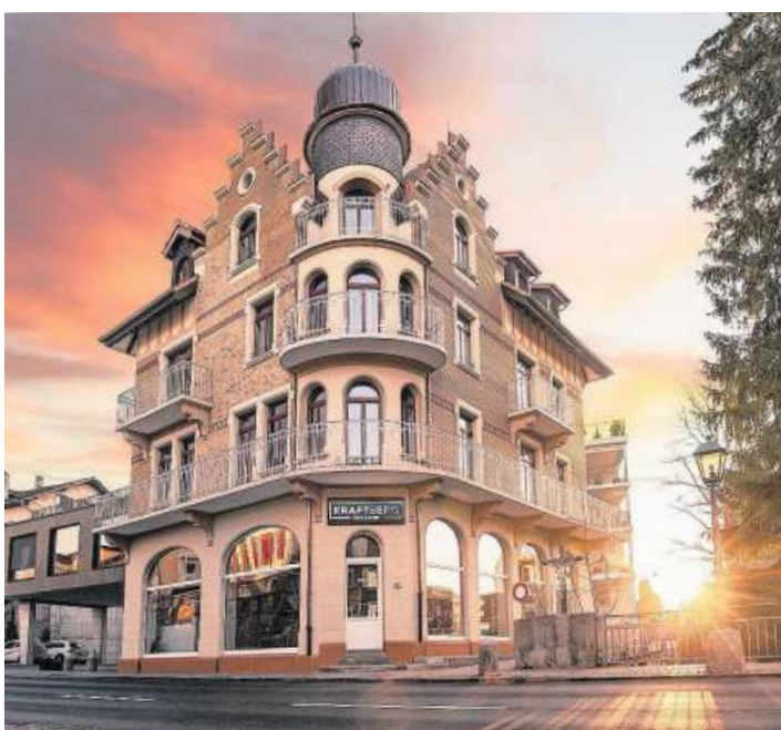
Der Kraftberg heute nach der Sanierung.
